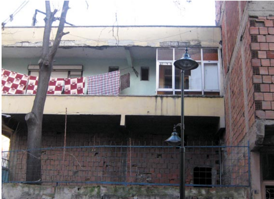
Tamamlanmış ikinci kat, tamamlanmamış birinci kat
