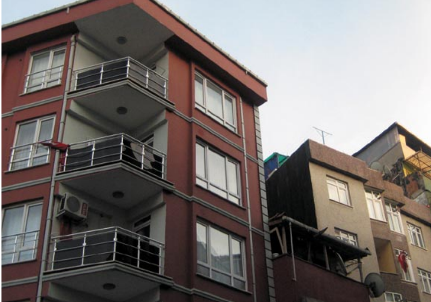
Eski binaların yanında yeni bina
