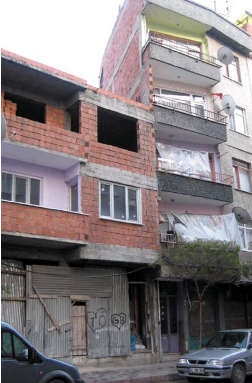
Binalar arasında devam eden inşaat
