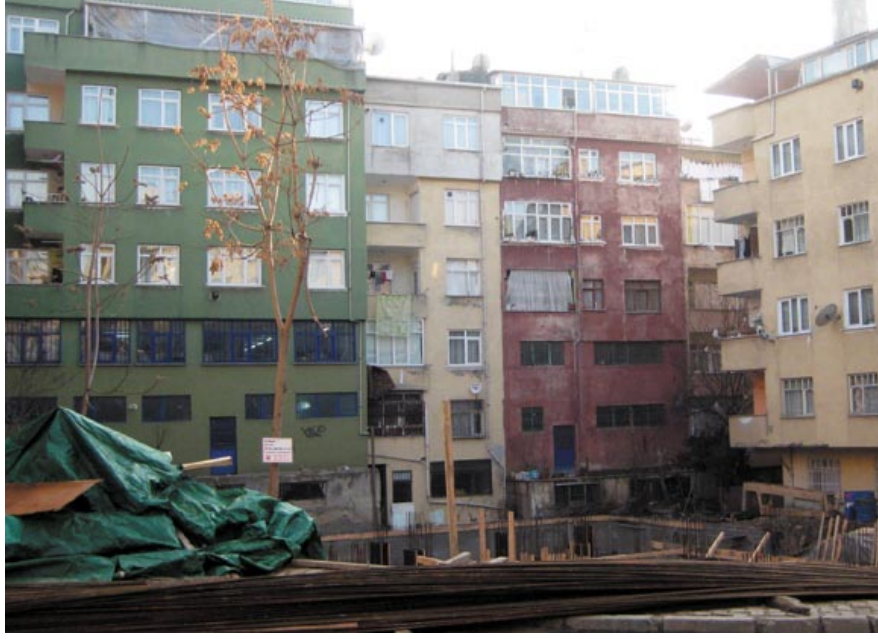
Çok katlı binalarla çevrelenmiş inşaat alanı
