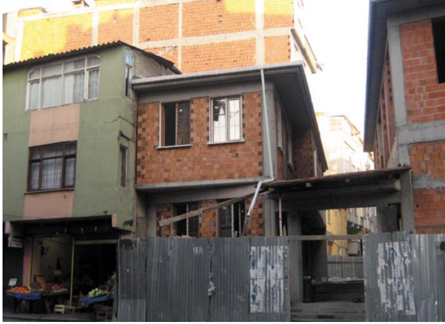
İki katlı bina inşaatı
