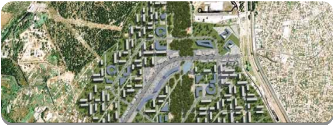
Şekil 17. Kepezaltı Santral Kentsel Dönüşüm
