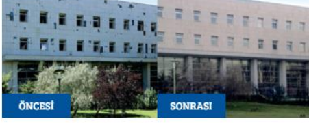
Ziyaretçi Kabul Binası
