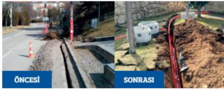
Santral Altyapısının Yenilenmesi
