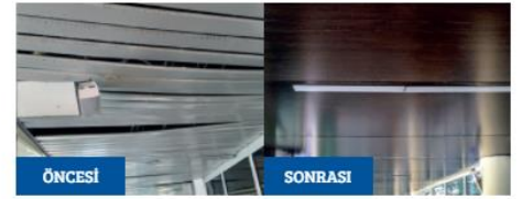
Beştepe Eğitim ve Sosyal Tesislerde Yapılan Tadilatlar
