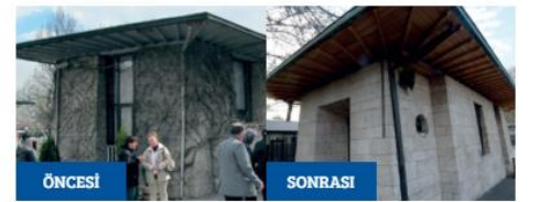
Dikmen Kapı Nizamiyesi Ahşap Tadilatları
