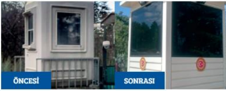
Güvenlik Tedbirleri Kapsamında Yapılan Tadilatlar
